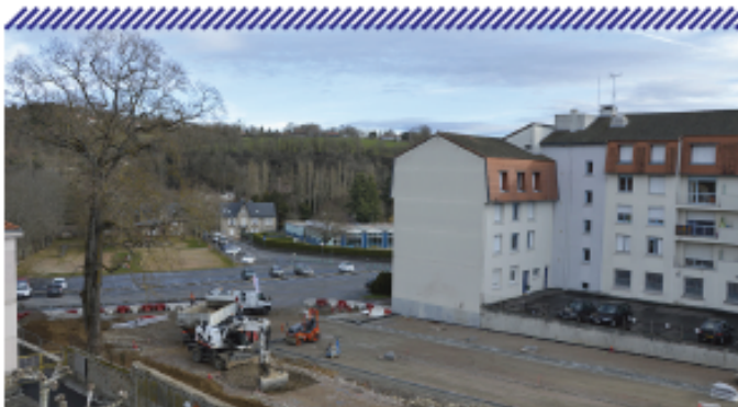
^ Travaux secteur René Gillet
