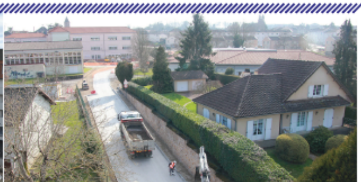
Travaux rue G-E Clancier
